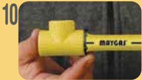
Transcurrido el tiempo mínimo de calentamiento indicado en la **tabla 2**, retirarlos de las boquillas y unirlos entre sí, dejando entre 1 y 2 mm de tubo expandido a la vista, sin que importe la posición del aro testigo. Déjelo enfriar durante al menos 2 minutos.
