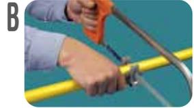
Utilice solamente una **sierra y una guía** para asegurar la perpendicularidad. Para evitar rebabas la hoja de sierra debe ser de 32 dientes.
