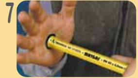
Para facilitar y agilizar la unión, es conveniente posicionar el buje en el extremo expandido del tubo y completar la introducción presionándolo contra la palma de la mano.
